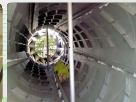
All'interno del tamburo Internal view of the drum
